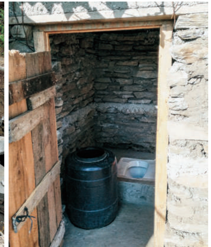
新設されたトイレ ©日本赤十字社
