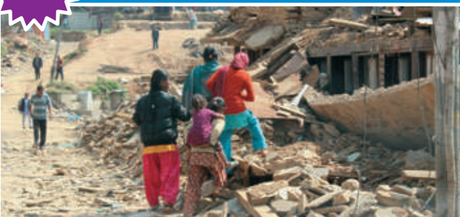
倒壊した山間部の住宅 ©日本赤十字社
